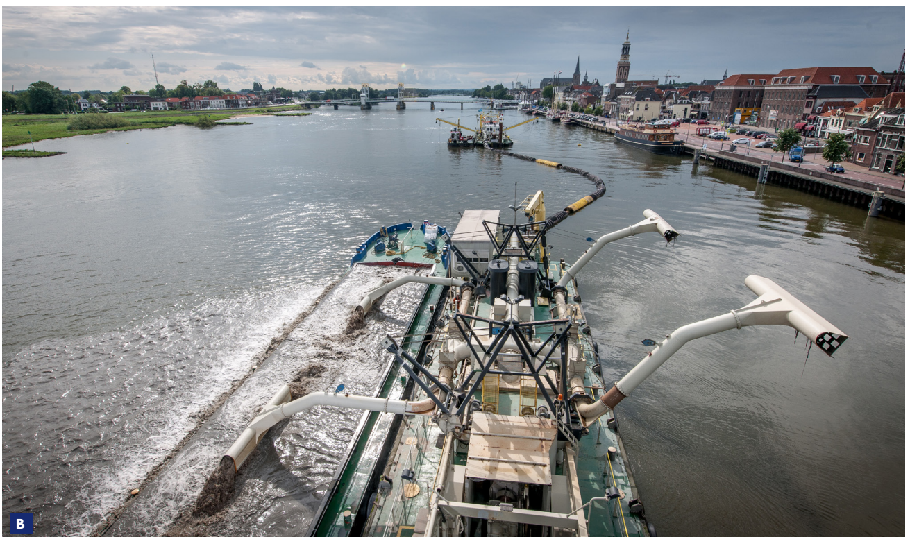
B Bakkenlader Olst aan het werk langs de historische binnenstad van Kampen
