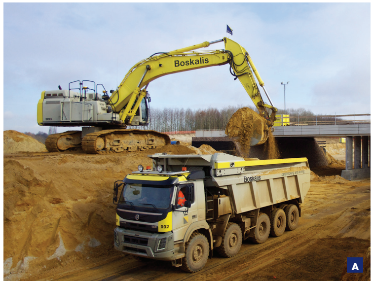
A Werkzaamheden in uitvoering
