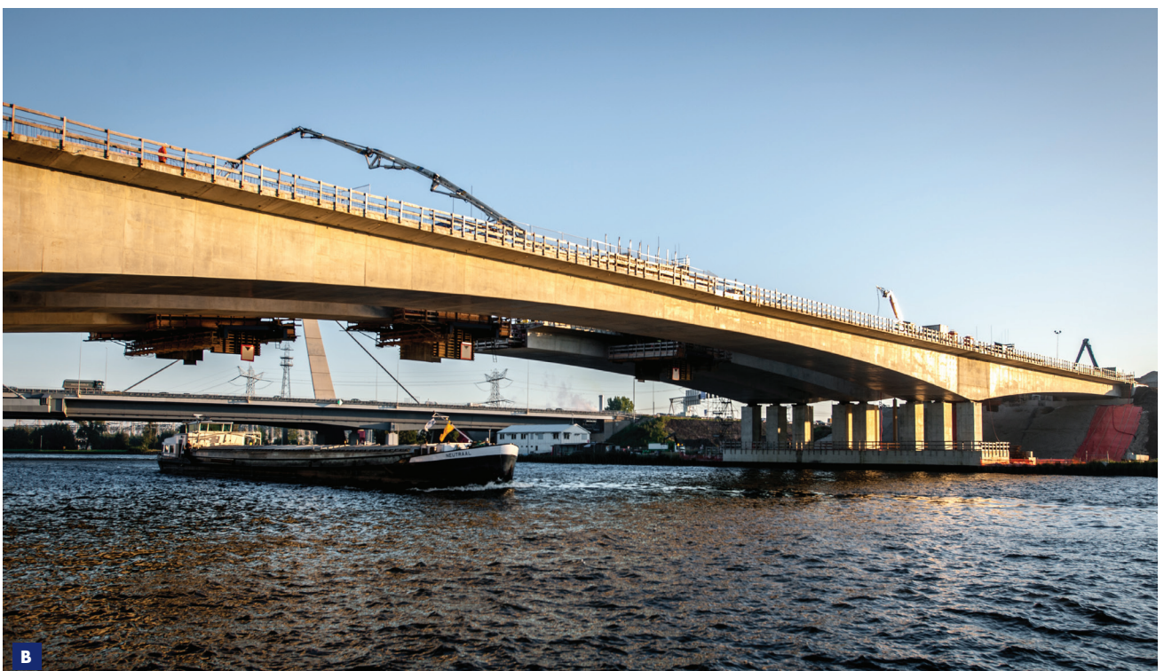
B Brug over het Amsterdam-Rijnkanaal in aanbouw
