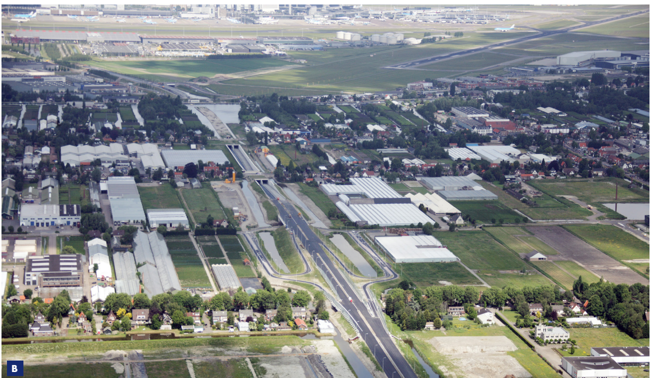
B Overzicht N201 met de tunnel richting de Schipholzijde
