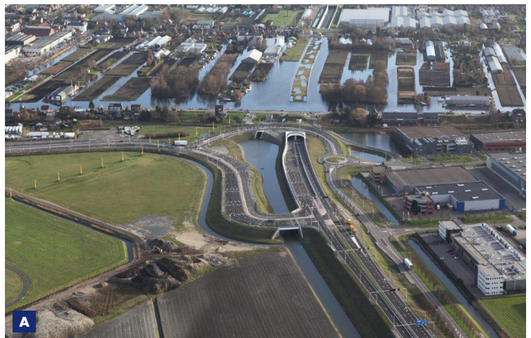
A Overzicht tunnel vanaf de Schipholzijde
