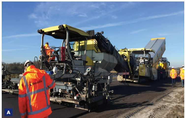
A Aanleg asfalt N381
