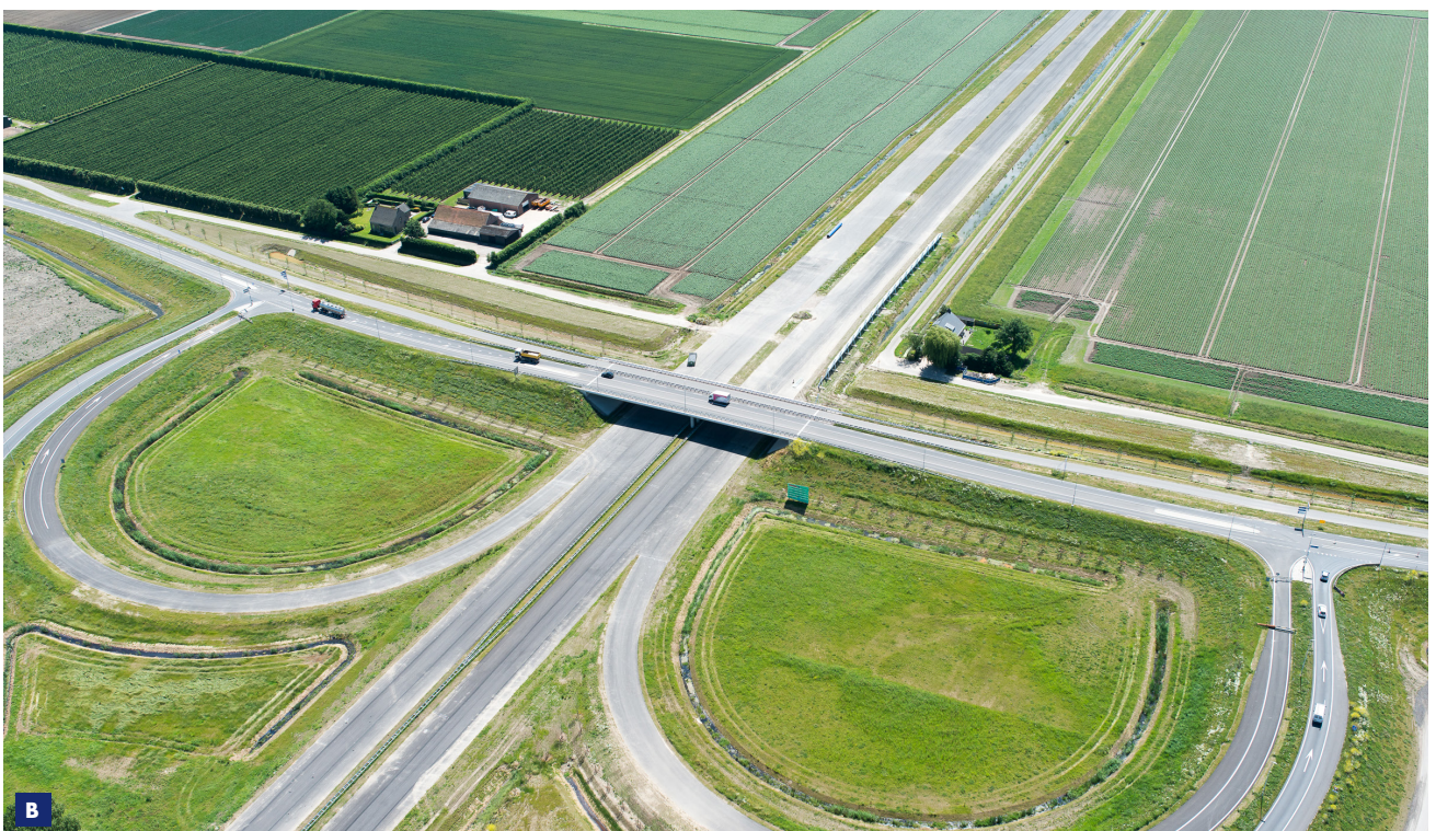
B luchtfoto knooppunt Dinteloord, viaduct Prinseland
