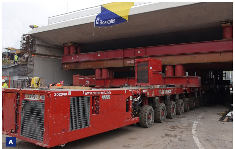
A Plaatsing viaduct
